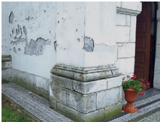
10 Elektroniczna ochrona kościoła przed wilgocią
