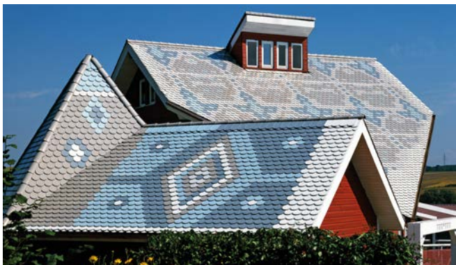
35 Dach jak obraz...
