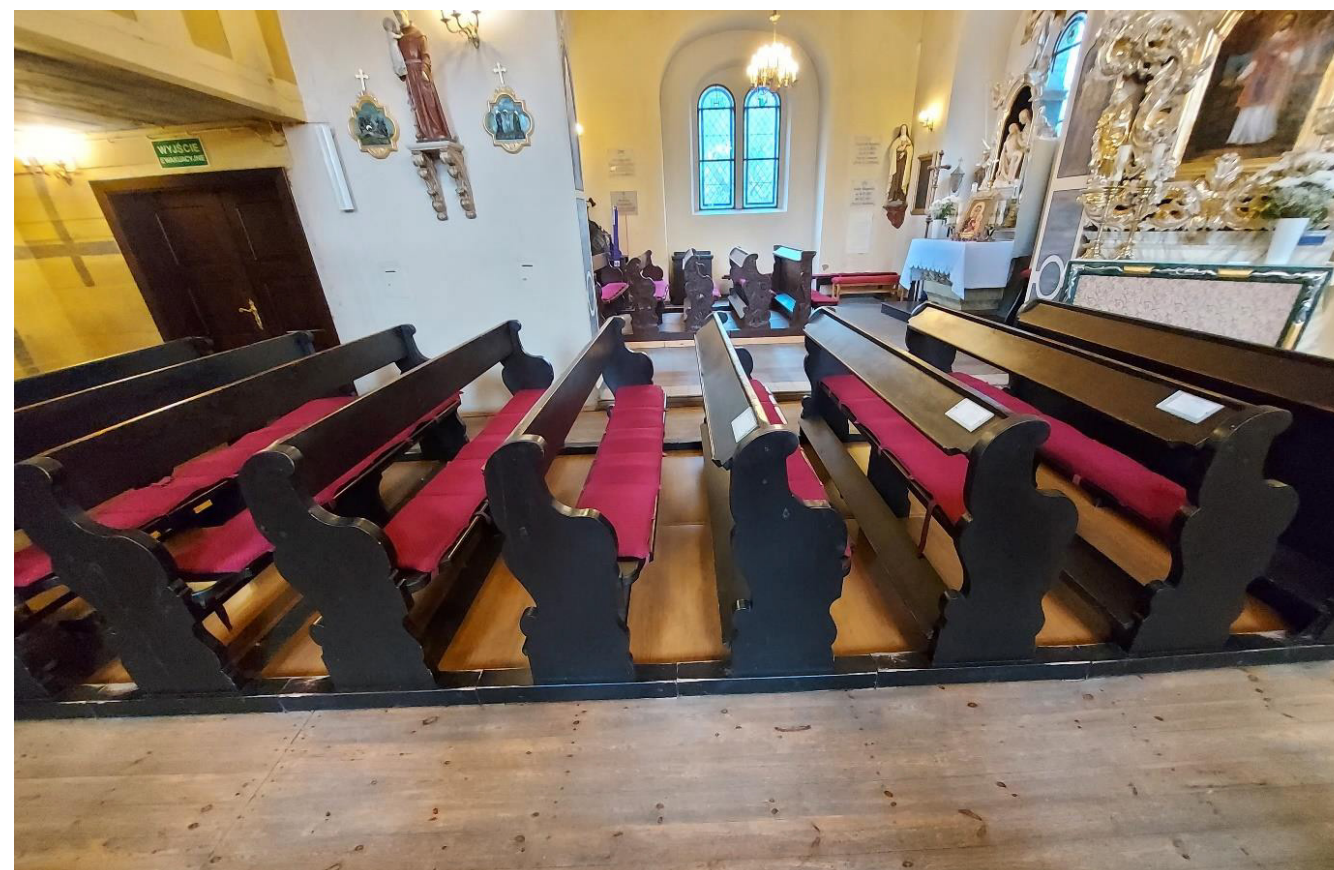
Panele grzewcze pod ławkami w kościele pw. św. Katarzyny w Potulicach
