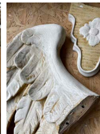
Uzupełnianie ubytków zapraw
