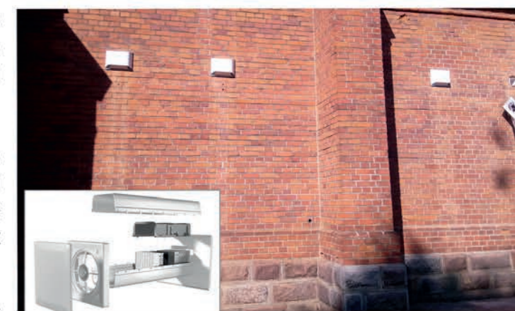
Rekuperacja - parafia pw. św. Zygmunta, Łosice
