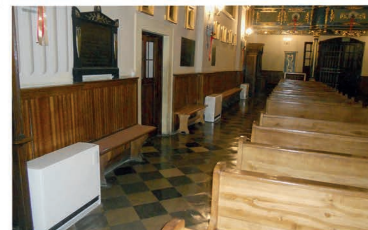
Piecy akumulacyjne - parafia pw. św. Jakuba Apostoła, Skaryszew
