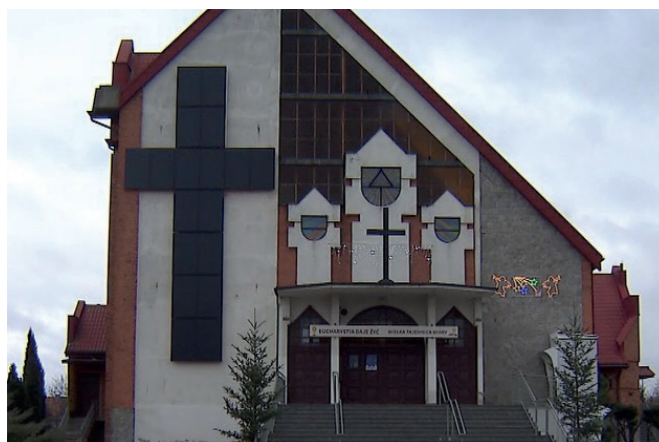
Fot. 5. Panele fotowoltaiczne na elewacji kościoła Matki Boskiej Częstochowskiej w Pleszewie (fot. Polsat News)
