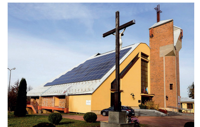
Fot. 4. Panele fotowoltaiczne na dachu kościoła św. Floriana w Sosnowcu (fot. Gość Niedzielny)
