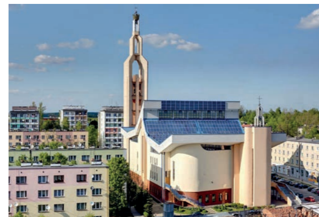
Fot. 3. Sanktuarium Matki Bożej Nieustającej Pomocy w Jaworznie z instalacją fotowoltaiczną na dachu (fot. Sanktuarium M.B.N.P. w Jaworznie)
