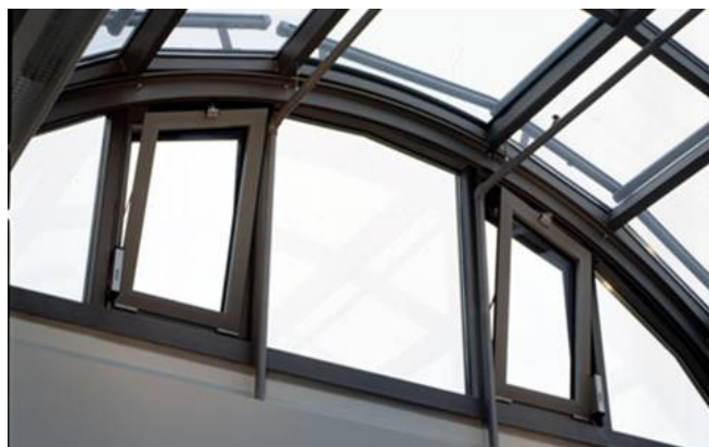
Fot. 5. Przykładowe zastosowanie otwieraczy z napędem liniowym typu E 212
