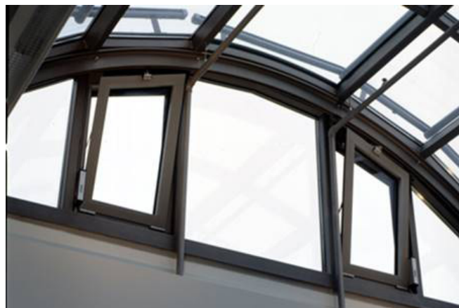
40 Otwieranie wysoko usytuowanych okien...
