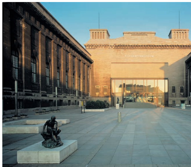
10 Renowacja i uszczelnienie...
