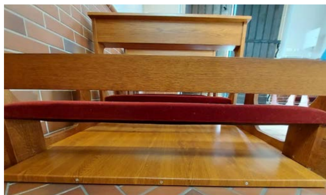
Podłogowe podesty grzewcze pod ławkami kaplicy przy kościele pw. św. Wawrzyńca w Rudzie Śląskiej
