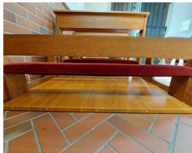
Podłogowe panele grzewcze pod ławkami kaplicy przy kościele pw. św. Wawrzyńca w Rudzie Śląskiej
