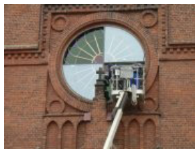
Fot. 5. Montaż dodatkowego okna
